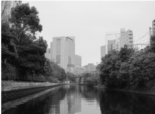
図5 緑被されている護岸 （茗溪（お茶の水溪谷））
