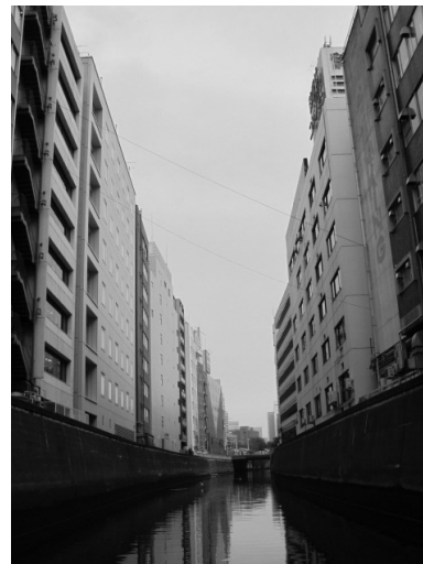
図3 ビルとコンクリート護岸によって「まち」から分断された神田川(水道橋付近)
