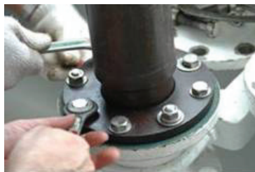
Photo.11 給油ホース接続部コネクター
