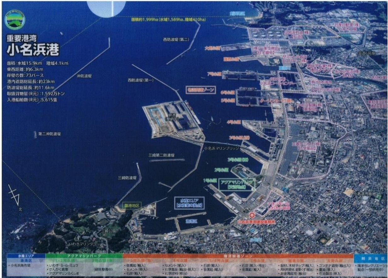
写真 4 小名浜港の全貌
