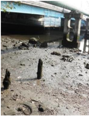
(a) 天王洲橋下 (砂泥地) 東京都港区
