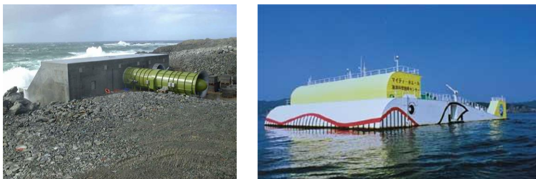
Fig. 1-3 Oscillating water column type wave energy converters (left: LIMPET, right: Mighty Whale). (出典: LIMPET 報告書 (21) および JAMSTEC ホームページ)
